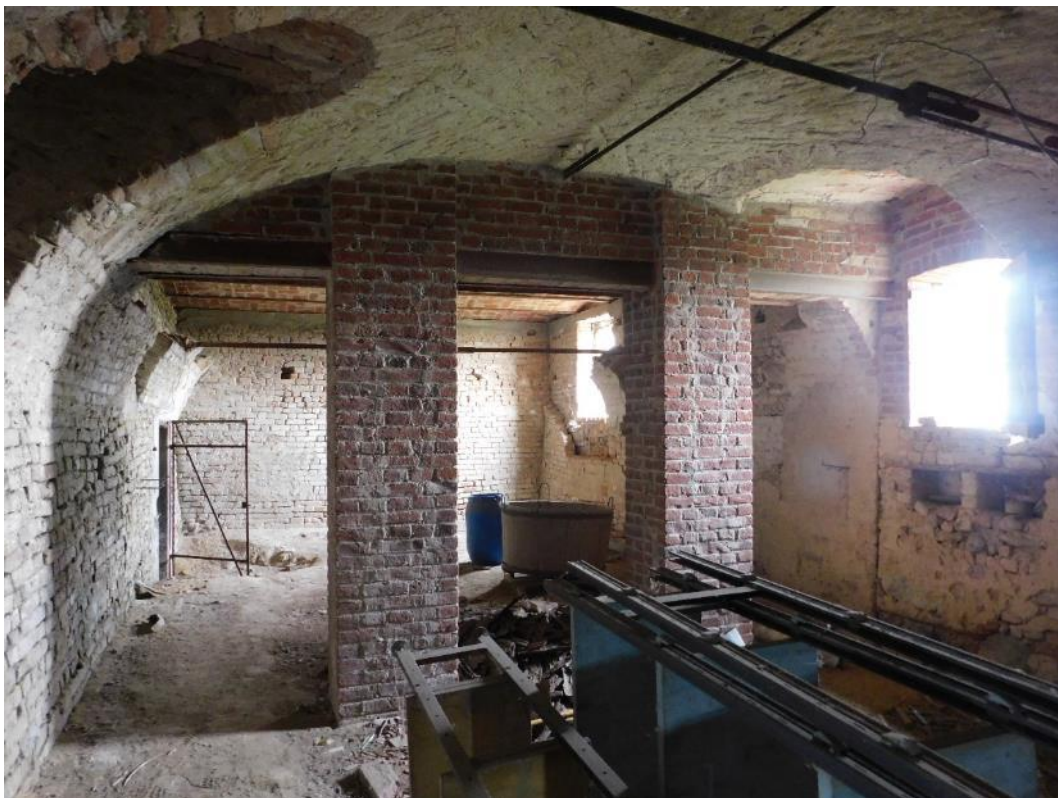
Fig. 12. Vista locale seminterrato
