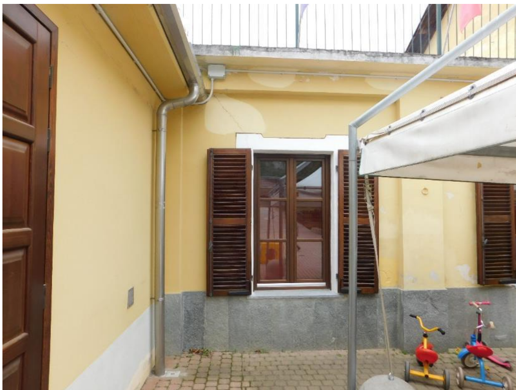
Fig. 7. Vista lato cortile, Prospetto Nord
