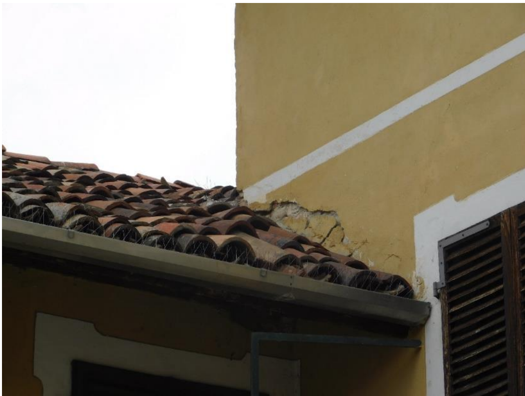
Fig. 11. Vista ravvicinata lesione
