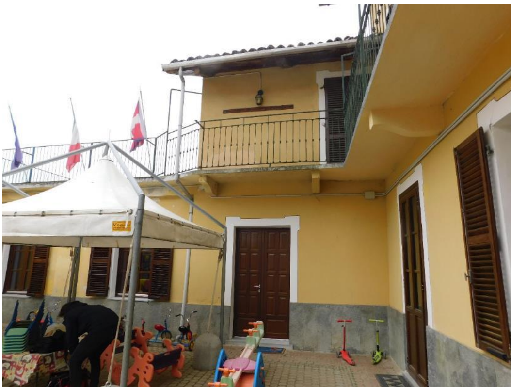
Fig. 6. Vista lato cortile, Prospetto Nord
